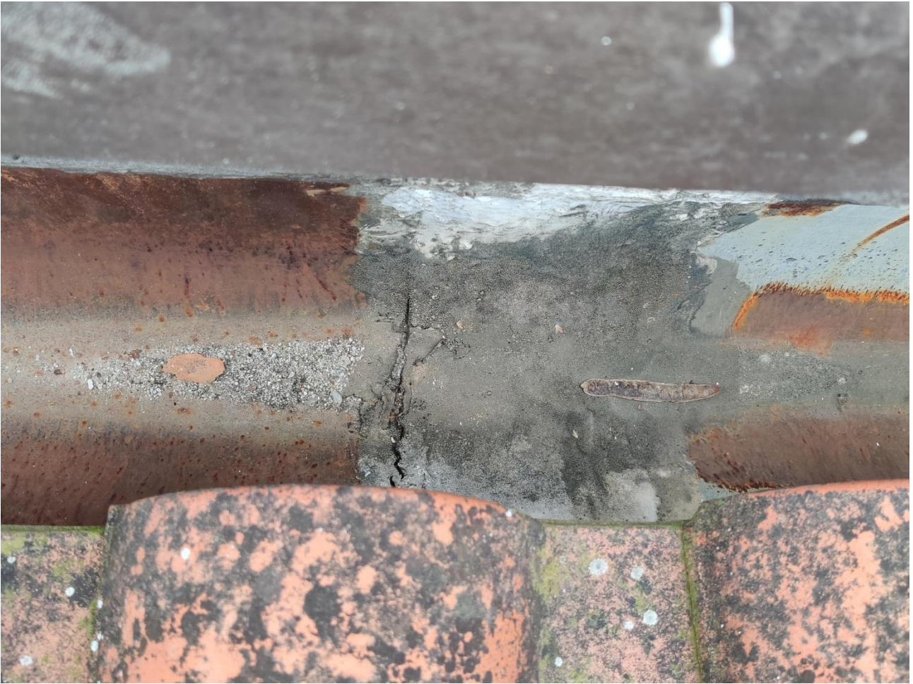
Εικόνα 2: Ενδεικτική κατάσταση οριζόντιας υδρορροής
